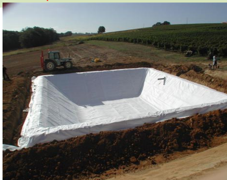
Mise en place Géo membrane drainante anti racinaire
